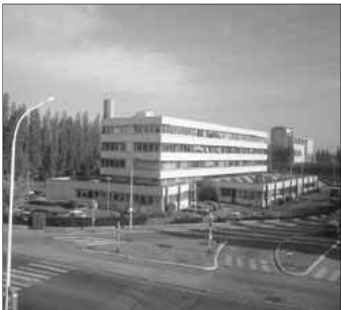
Head Office - Rosny sous Bois
