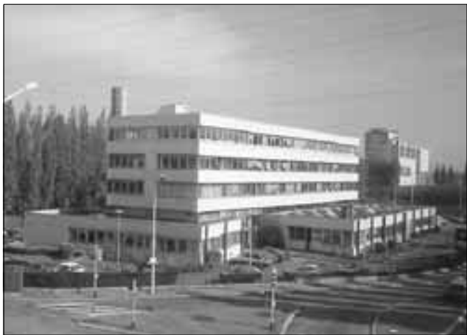
Head Office - Rosny sous Bois
